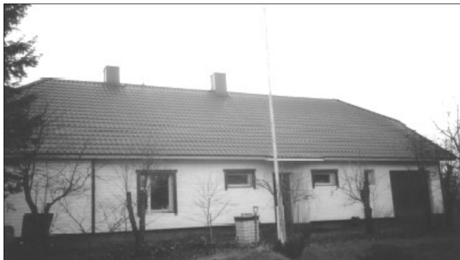
Tuuleveski elumaja pärast 2006. aasta remonti sissesõidutee poolt vaadatuna
